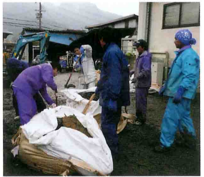
堆積した大量の土を撤去する支援隊
