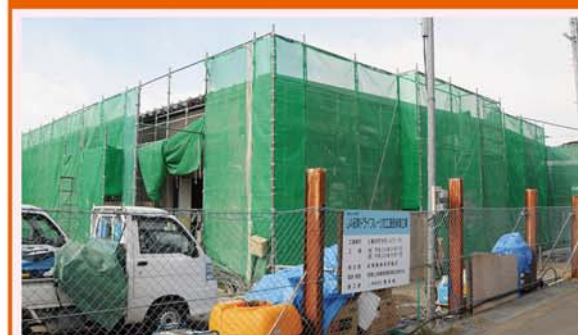
上富田町に建設中のドライフルーツ加工施設
