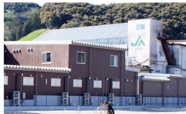
中芳養加工場に完成した梅干し製造棟(令和6年3月)
